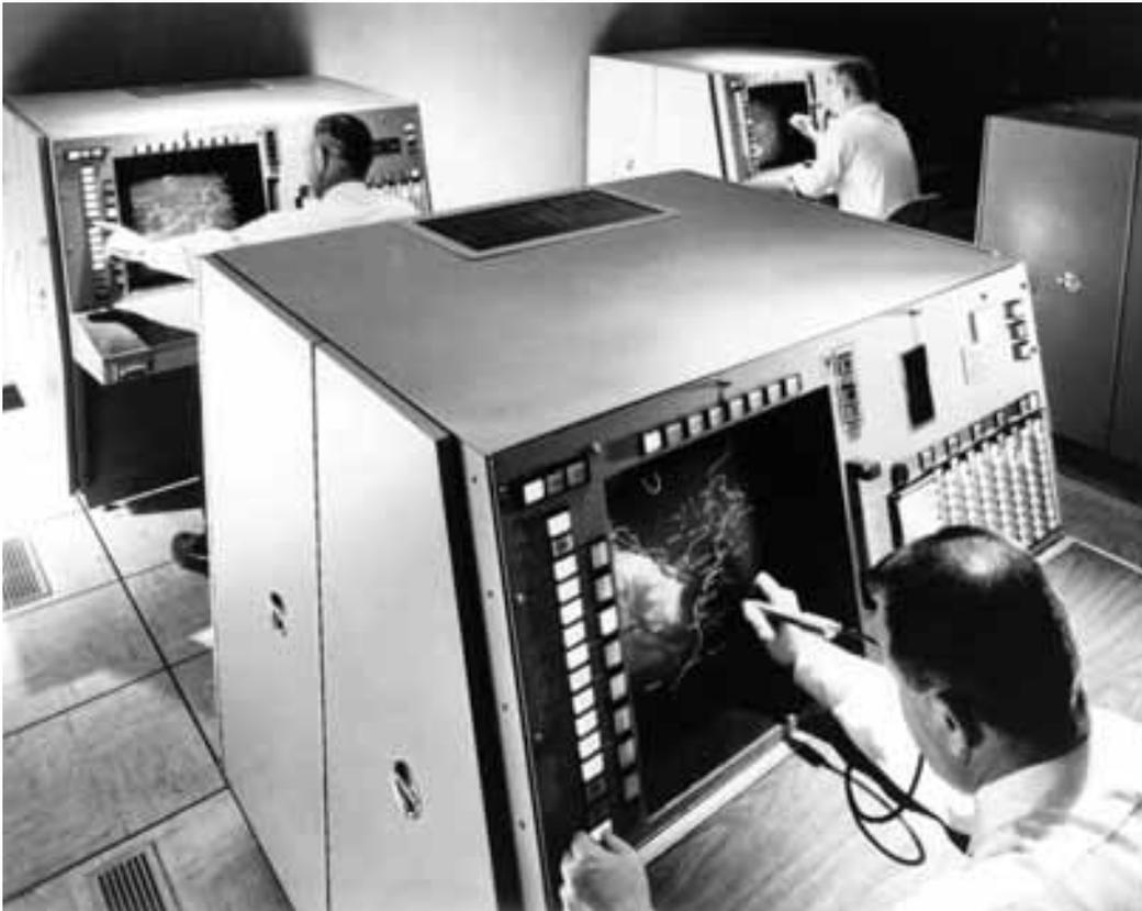
**Abb. 37.** Computergestütztes Luftabwehrsystem der USA ca. 1960 – ein graphisch-interaktives System mit Radarbildschirm und Lichtgriffel
