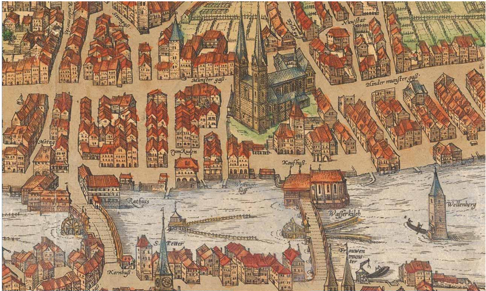
Detailausschnitt aus der kolorierten Radierung (Gesamtgrösse: 36.3 x 48.8 cm) mit Turmspitzen St. Peter und Fraumünster, Grossmünster, Rathaus, Wasserkirche, Haus zum Rüden, Münsterergasse, Rindermarkt, Metzgergasse, Stüssi-Brunnen. Der Wellenbergturm, der auch als Gefängnis diente und Teil der Stadtbefestigung war, existiert heute nicht mehr; er störte den Verkehrsfluss auf der Limmat und wurde daher 1837 abgetragen.
