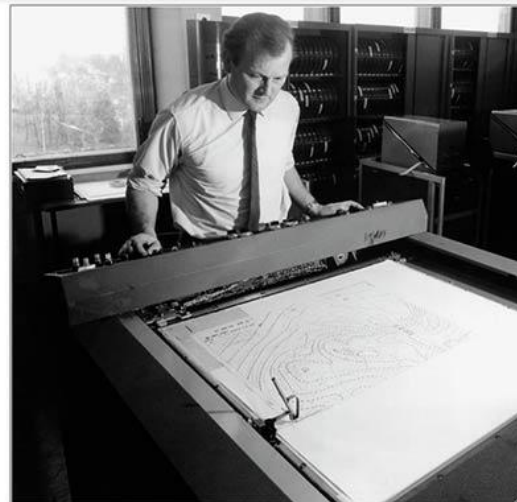
Datenverarbeitung im britischen Met-Office der 1960er-Jahre: Lochkarten, Lochstreifen, Magnetbänder sowie ein Plotter.
