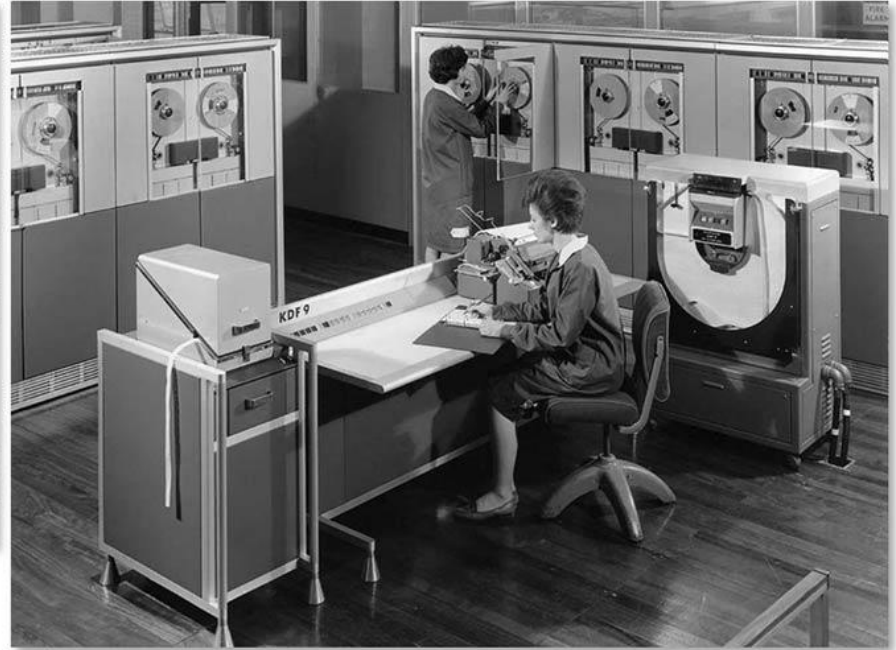
Datenverarbeitung im britischen Met-Office der 1960er-Jahre: Lochkarten, Lochstreifen, Magnetbänder sowie ein Plotter.
