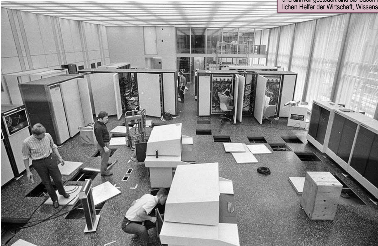
1970: Aufbau des CDC 6400/6500-Computers von Control Data im neuen Rechenzentrumsgebäude („RZ“) in der Clausiusstrasse 59
