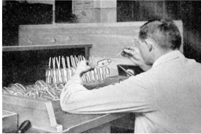
Einschmelzen des Fußes in den Kolben
