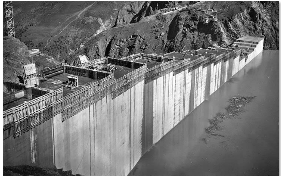
Bau der Staumauer der Grande Dixence zwischen 1951 und 1965; mit einer Höhe von 295 m war dies damals die höchste Staumauer der Welt. (Bild: www.atlasofplaces.com/architecture/barrage-de-la-grande-dixence/ )
