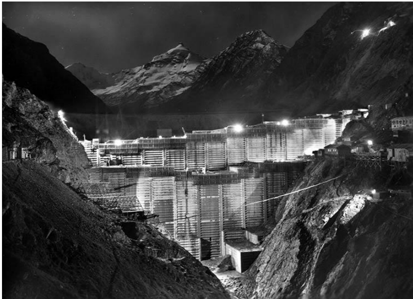
Bau der Staumauer der Grande Dixence zwischen 1951 und 1965; mit einer Höhe von 295 m war dies damals die höchste Staumauer der Welt. (Bild: www.atlasofplaces.com/architecture/barrage-de-la-grande-dixence/ )
