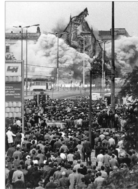
Als ohnmächtige Zuschauer gedeutet, drängten sich am Tag der Sprengung einige Tausend Menschen hinter den Absperrungen.
