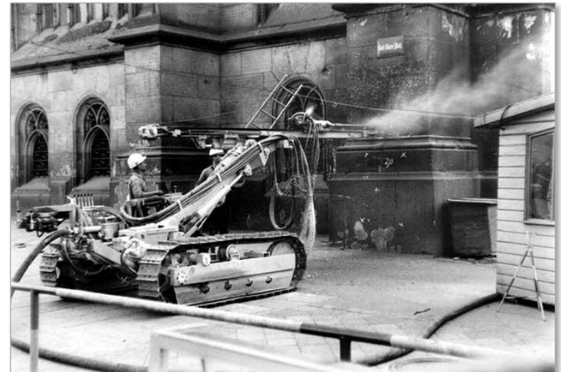
Bohrung der Sprenglöcher.
