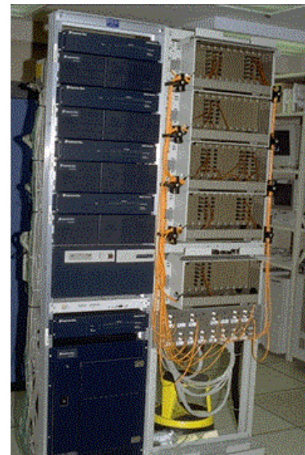
Linkes Bild: Router und Hub im linken Rack; Patchfeld für Lichtwellenleiter im rechten Rack; rechtes Bild: Router und Hub mit Twisted-Pair-Kabeln
