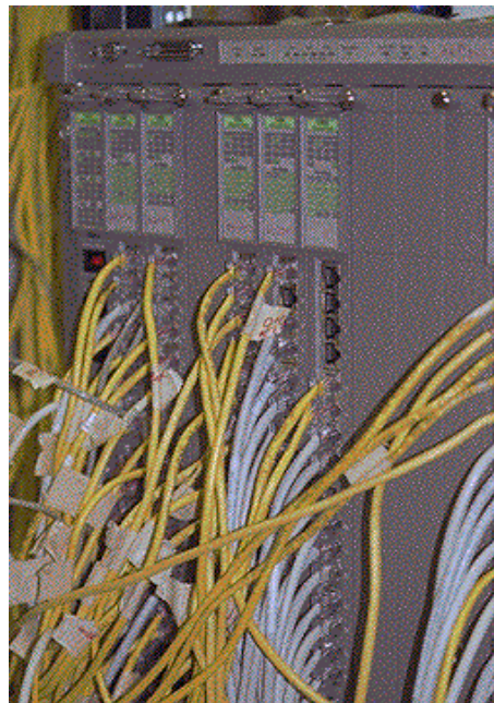
Linkes Bild: Router und Hub im linken Rack; Patchfeld für Lichtwellenleiter im rechten Rack; rechtes Bild: Router und Hub mit Twisted-Pair-Kabeln
